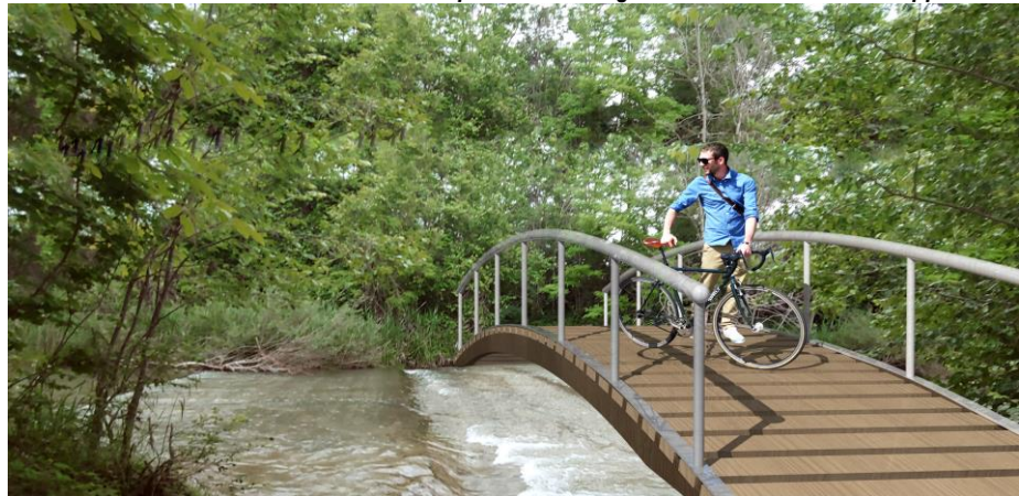
Il ponte che collega la zona industriale a via Appechiesa
